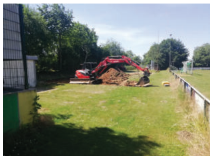
Der Bagger rückt an und hebt die Baugrube 40 cm tief aus.
