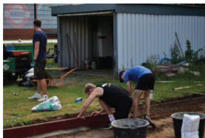
Die Randsteine aus Gummi werden auf dem 12 x 22 m großen Areal gesetzt.
