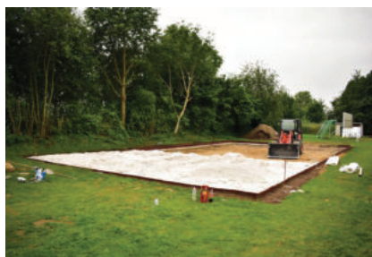
Der erste Sand wird ins neue Beachfeld per Radlader transportiert.
