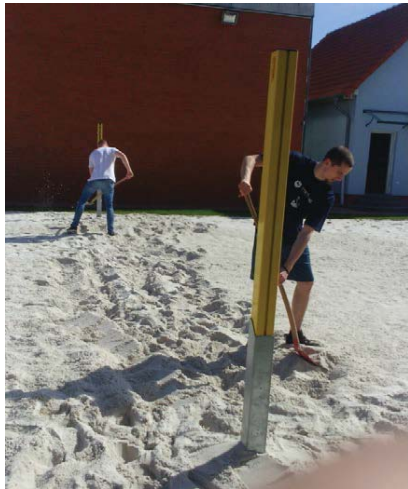
Basti und Martin haben die Pfosten aufgestellt und begradigen das Feld.
