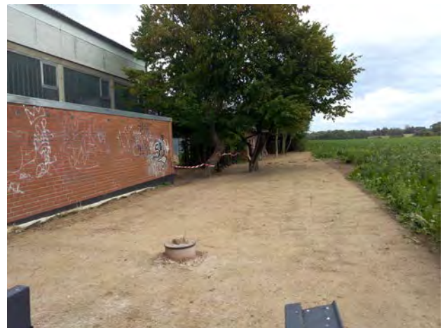
Blick aus Richtung Volleyballheim auf das hergerichtete Gelände.
