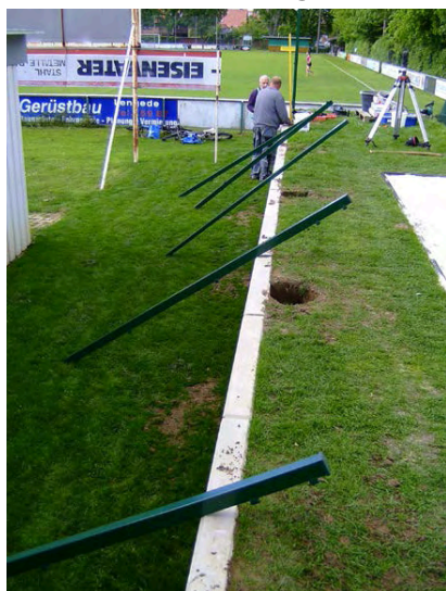
Sprechen sich bei der Vorbereitung zum Setzen der Zaunpfähle ab, im Hintergrund zu sehen sind Willi Hoffmann und Andreas Genz .
