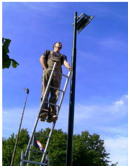
Der Herr der Lüfte! Holger Andreä justiert den Strahler.
