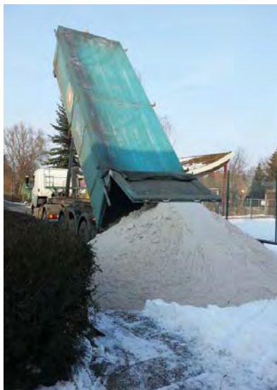
7 LKW-Ladungen mit insgesamt 175 Tonnen Quarzsand liegen nunmehr in der Beachvolleyballanlage.
