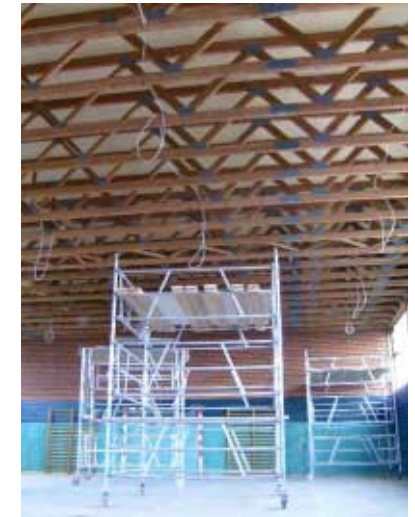
Während der Bauarbeiten
